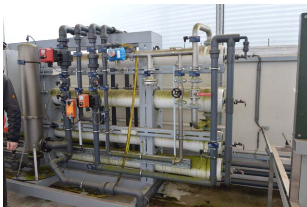
Fot. 36. Filtr odwróconej osmozy (W. Treder)
