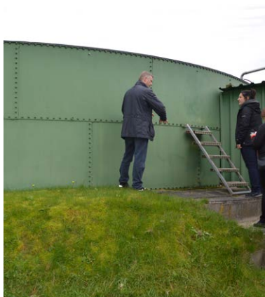
Fot. 37. Spowolniony filtr piaskowy wykonany z płyt stalowych (W. Treder)
