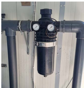
Fot. 26. Filtr wyposażony w manometry (W. Treder)
