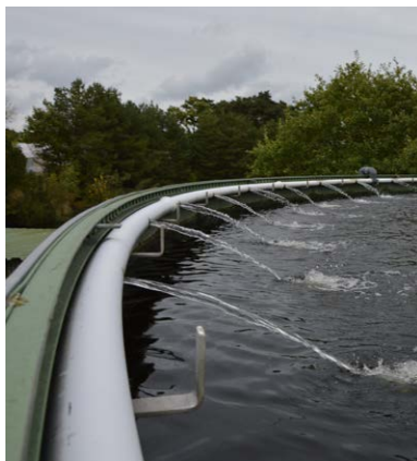
Fot. 37. Spowolniony filtr piaskowy wykonany z płyt stalowych (W. Treder)
