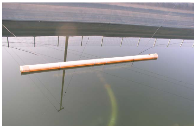
Fot. 41. Pływające ujęcie wody (W. Treder)
